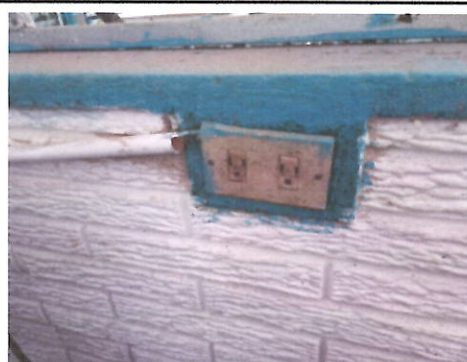
Foto 2: Sustitucion de sistemas de iluminación: tomacorrientes de pared de 110v
