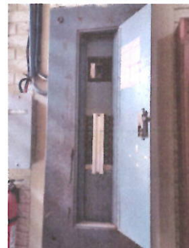
Foto 4: SUSTITUCION DE TABLERO DE 18 POLOS, POR TABLERO DE 24 POLOS MONOFASICO 24X200A ELECTRIX
