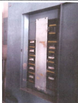
Foto 5: SUSTITUCION DE TABLERO DE 18 POLOS, POR TABLERO DE 24 POLOS MONOFASICO 24X200A ELECTRIX
