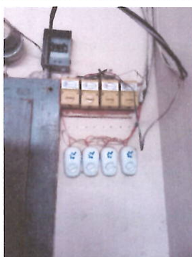
Foto 3: SUSTITUCION DE TABLERO DE 18 POLOS, POR TABLERO DE 24 POLOS MONOFASICO 24X200A ELECTRIX
